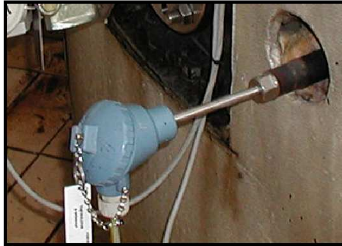
En Pt100 givare monteras ofta i ett s k dykrör, för att kunna bytas utan att påverka processen.
