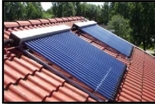
Solen värmer vätskan i panelerna på taket som sedan vidaretransporteras till varmvattenberedaren.
