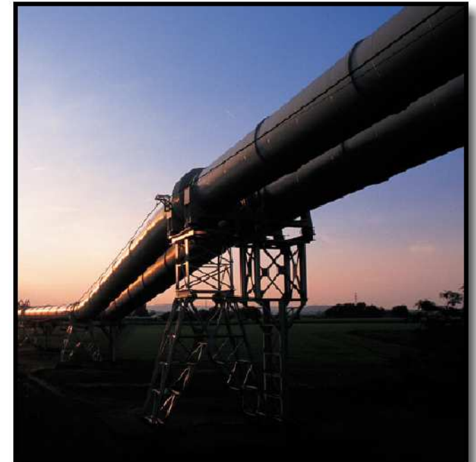
En ledning ovan jord för naturgas i USA, en pipeline
