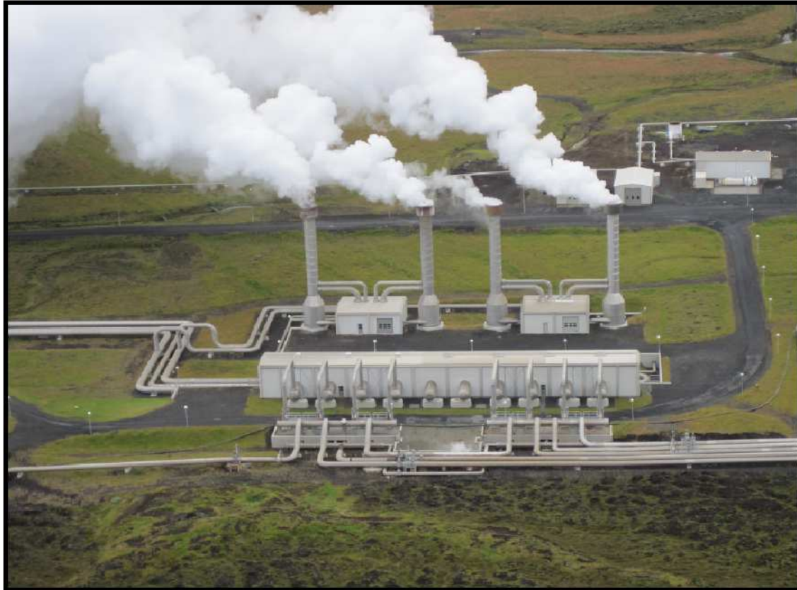
Det geotermiska kraftverket Nesjavellir på Island
