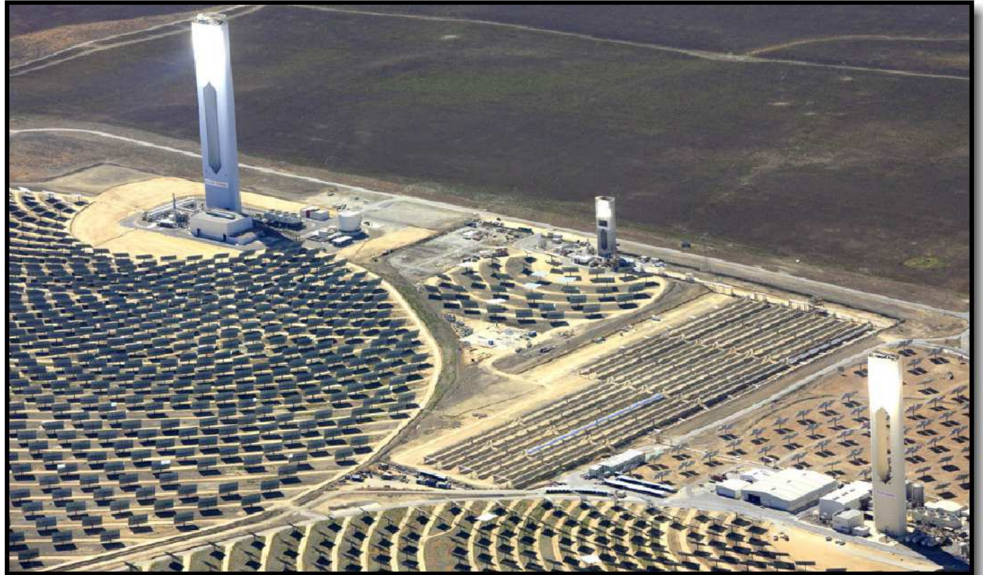
Termiskt solkraftverk i Sevilla i Spanien. Spegelarna reflekterar solens strålar som lyser mot en punkt uppe i tornens topp. Vätska värms som sedan blir till ånga som driver en turbin som genererar el.
