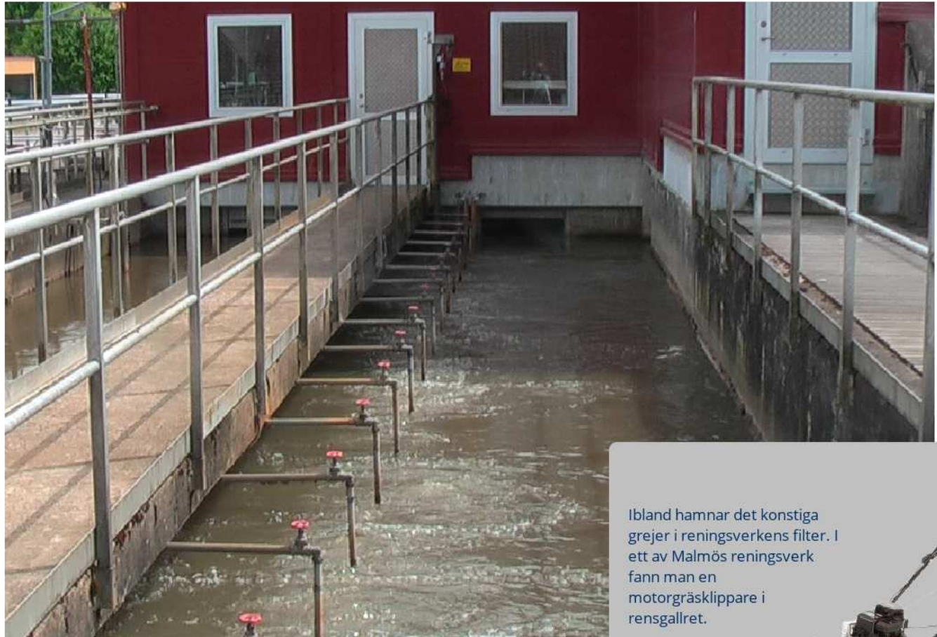
Luftning i den mekaniska reningen
