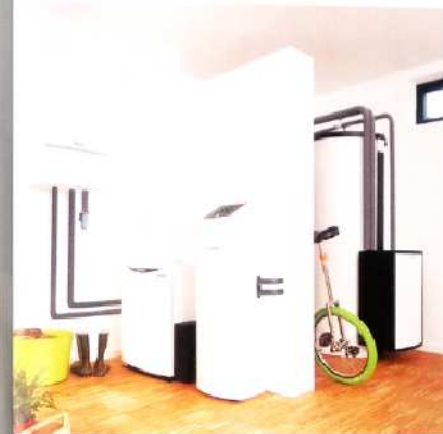
FIGUR 2. Kartongenerat i ett förbränningsmotorbaserat mikro-kraftvärmeverk. Rättymmerat gaspanna, mikro-kraftvärmeverk, multi-funktionell (energilager) och en extern värmedata för lagringsvärmes.
