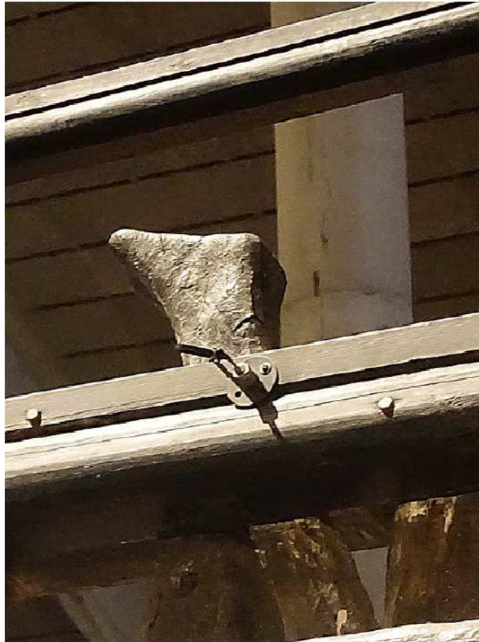
Sensorer placerade på skeppet på flera olika platser. Dessa är individuellt kopplade till kontrollboxar inne i skeppet. Dessa i sin tur för över informationen till fastighetsautomationssystemet.
