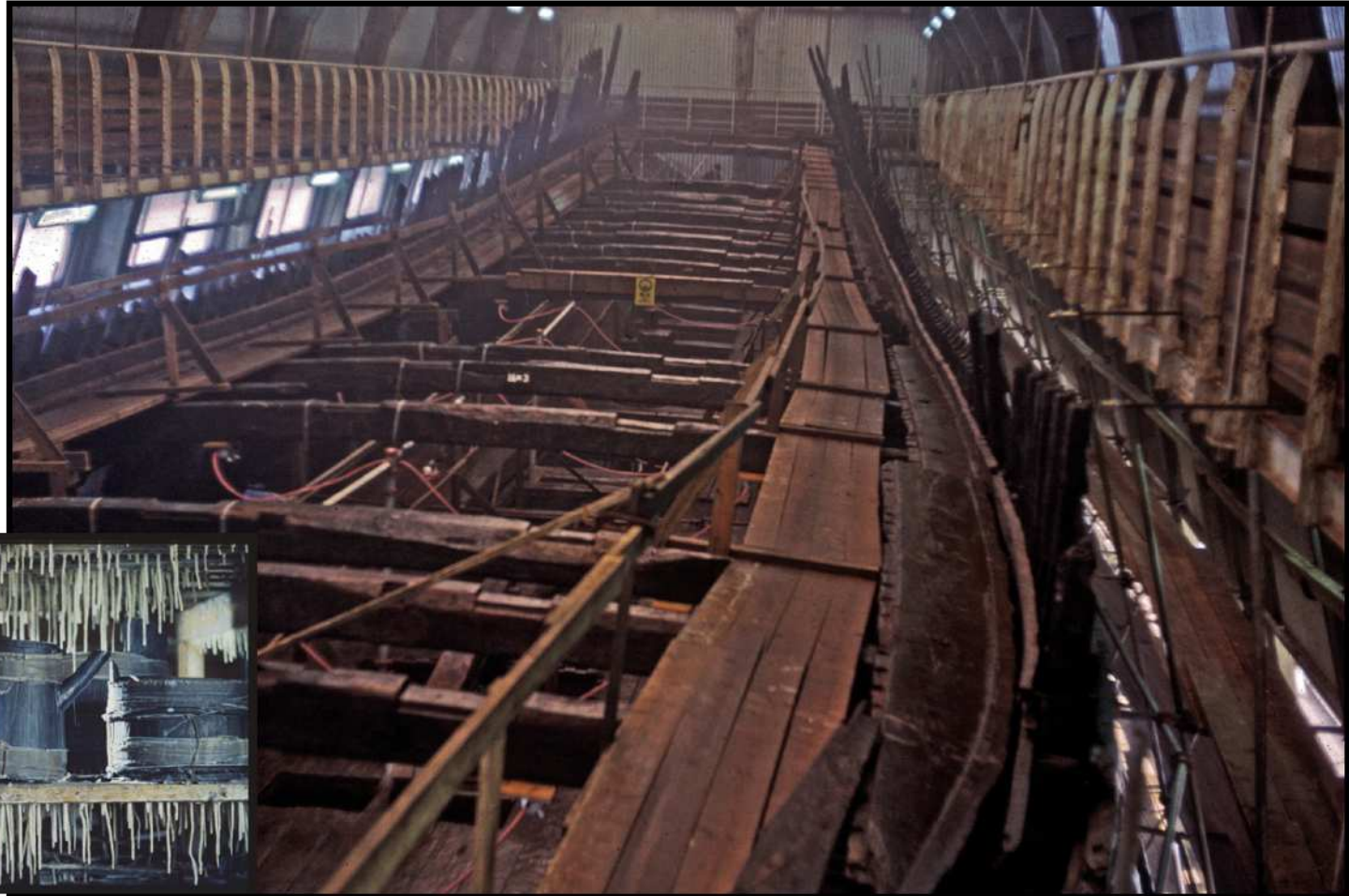
Vasa under impregnering 1965. Källa: Wikipedia. Lilla bilden; PEG-behandlade träföremål.
