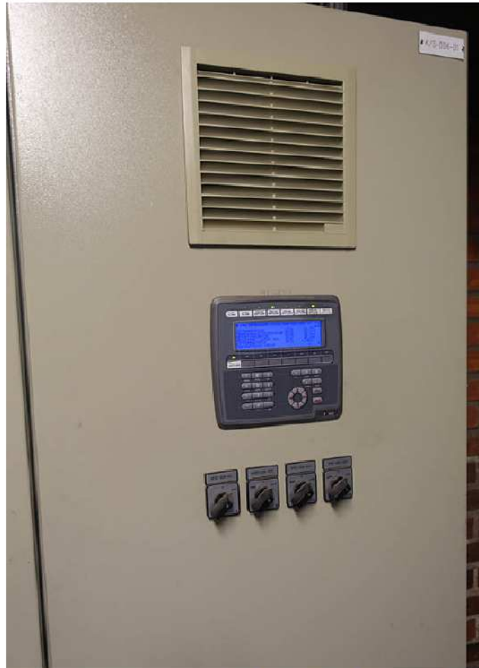
Olika typer av operatörsterminaler. Till vänster en äldre modell av en operatörsterminal och till höger en modern operatörsterminal.
