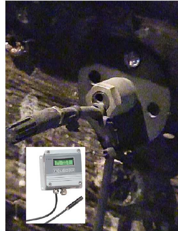
Sensorer placerade på skeppet på flera olika platser. Dessa är individuellt kopplade till kontrollboxar inne i skeppet. Dessa i sin tur för över informationen till fastighetsautomationssystemet.
