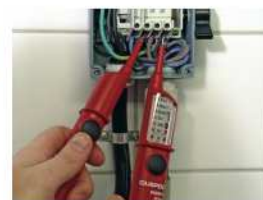
Gör spänningslös- hetskontroll
